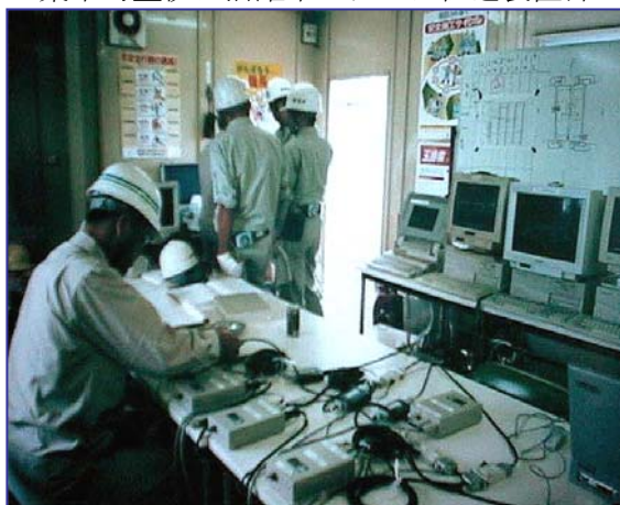
沈埋管沈設作業とデータ伝送装置群
