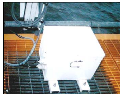
観測塔上の潮位計送信部の設置状況
